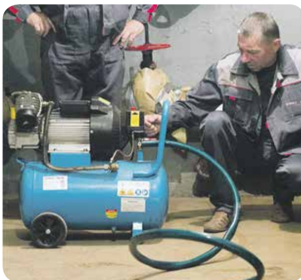
Гидроневопромывка систем отопления
